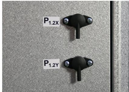
Luftmenge und Druckverlust über die Filter anhand der Formeln in der Tabelle ermitteln.
