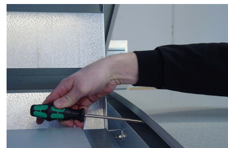
Asennus Sivulevyt työnnetään VEX-koneen päälle. Levyjä voidaan tarvittaessa kohottaa hieman ruuvitaltalla, jolloin ne asettuvat kunnolla paikalleen.
